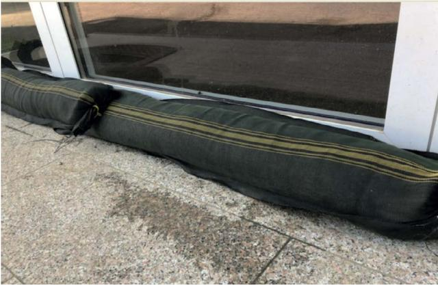
Abbildung 31: Vorgefüllte Sandsäcke bieten bei geringen Wasserständen guten und preiswerten Schutz.
