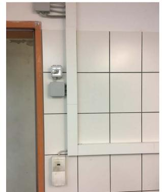
Abbildung 64: In gefährdeten Räumen sollten elektrische Leitungen unbedingt an der Decke verlegt werden. Als Wandverkleidung empfehlen sich Fliesen. Sie erlauben eine einfache und rasche Reinigung nach einem Wasser- oder Schlammeneintritt.
