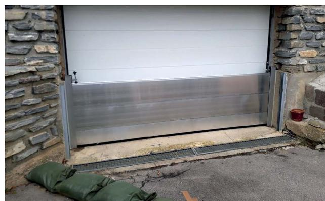
Abbildung 37: Mobiles Dammbalkensystem am Garagentor.
