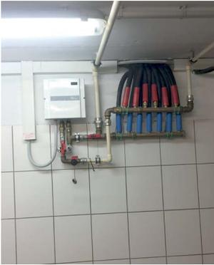
Abbildung 53: In potenziell überfluteten Bereichen sollten die Installationen möglichst hoch über dem Fußboden angebracht werden. Als Wandverkleidung haben sich Fliesen bewährt.
