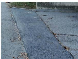
Abbildung 25: Bodenschwelle als Schutz vor Oberflächenabfluss in eine Tiefgarage.
