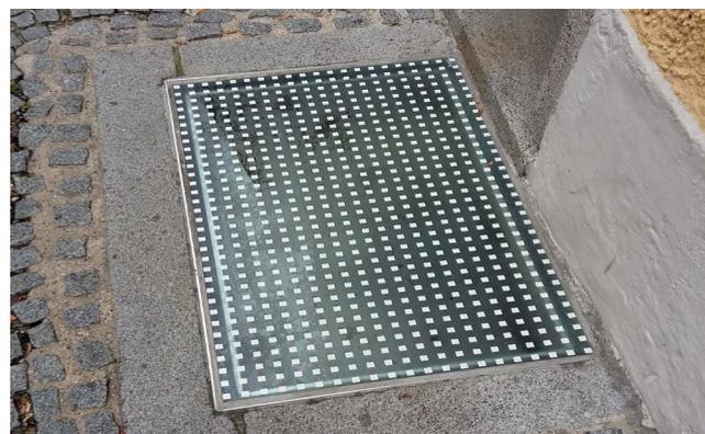
Abbildung 36: Abgedichteter Lichtschacht.
