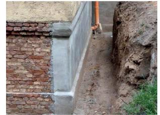
Abbildung 63: Nachträgliche Abdichtung mit wasserdichtem Sperrputz.
