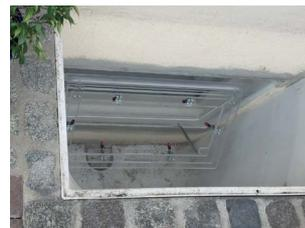
Abbildung 58: Wasserdicht verschließbares Kellerfenster.
