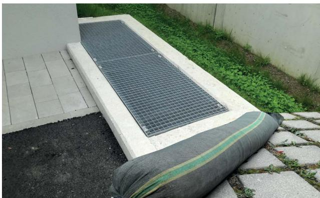
Abbildung 30: Kellerfenster mit erhöhtem Lichtschacht – zusätzlich durch Sandsack vor Wassereintritt geschützt.
