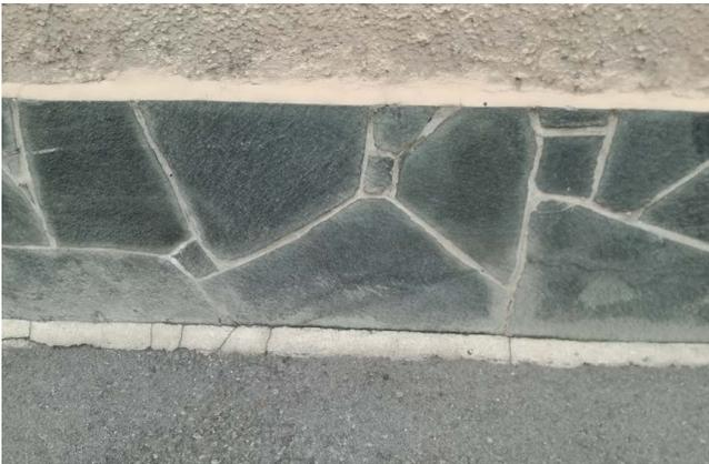
Abbildung 39: Abdichtung mit Verblendmauerwerk.
