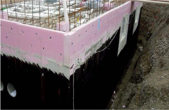
Abbildung 38: Im Sockelbereich sollten wasserunempfindliche Dämmmaterialien zum Einsatz kommen.
